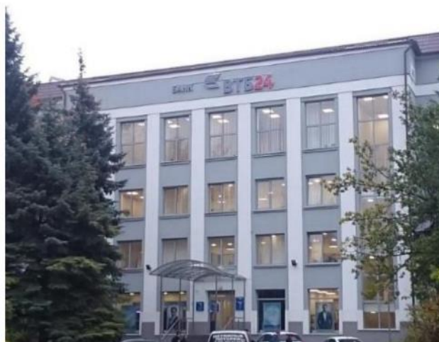
Фото 1. Общий вид нежилого здания, дом 28, пр-кт Ленинский, г. Калининград.
