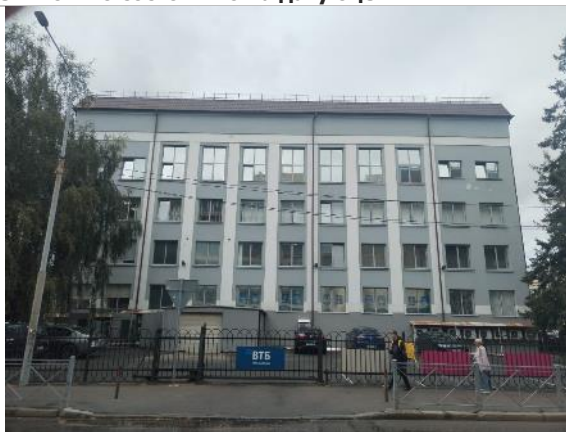
Фотография 2. Внешнее состояние объекта.
