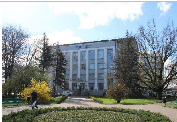
Фотография 1. Внешнее состояние объекта.
