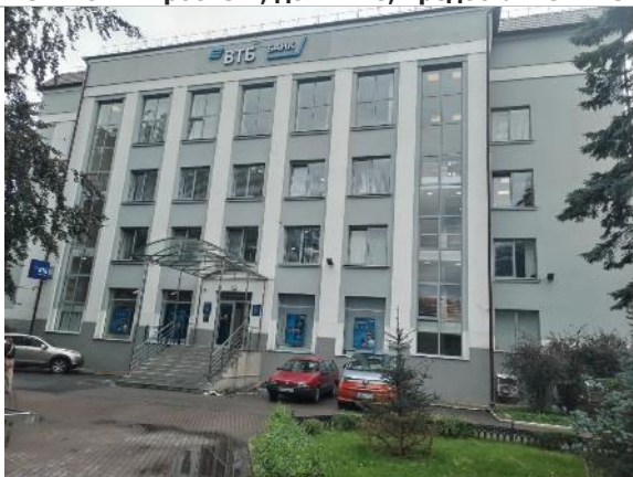
Фотография 1. Внешнее состояние объекта.
