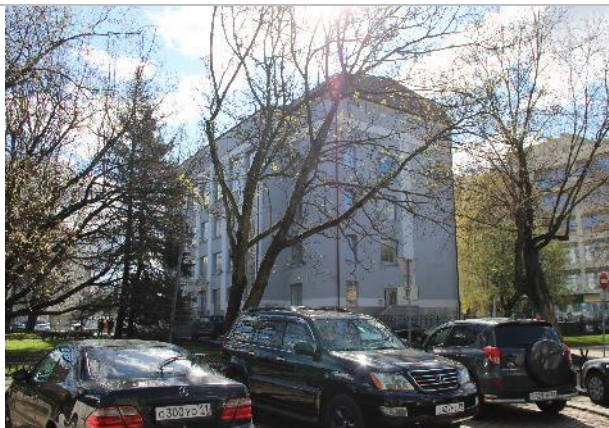
Фотография 2. Внешнее состояние объекта.
