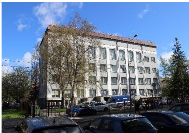
Фотография 4. Внешнее состояние объекта.
