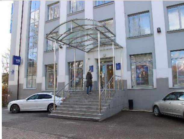
Фотография 11. Внешнее состояние объекта.
