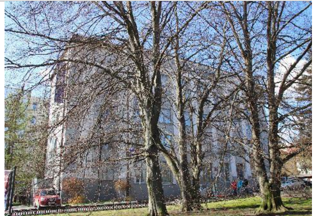
Фотография 10. Внешнее состояние объекта.
