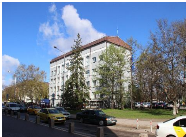
Фотография 5. Внешнее состояние объекта.
