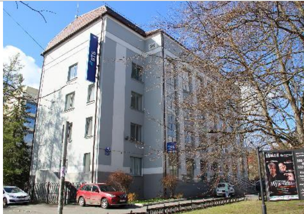
Фотография 9. Внешнее состояние объекта.
