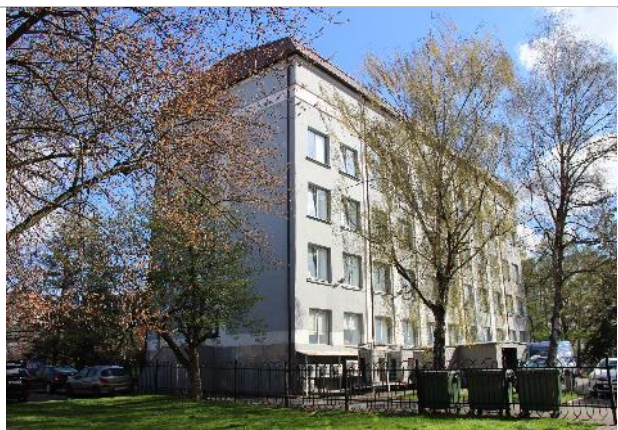
Фотография 3. Внешнее состояние объекта.
