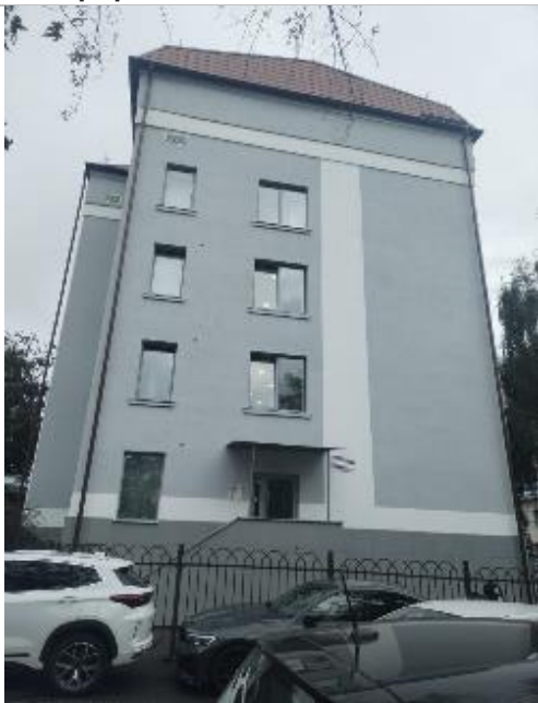
Фотография 3. Внешнее состояние объекта.
